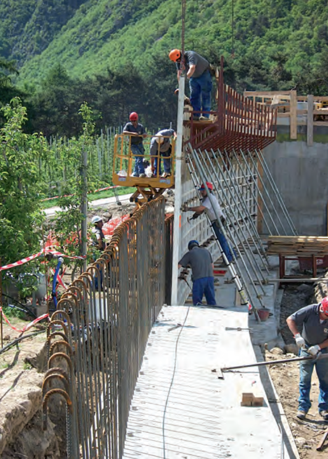
Operai al lavoro su un muro di contenimento
