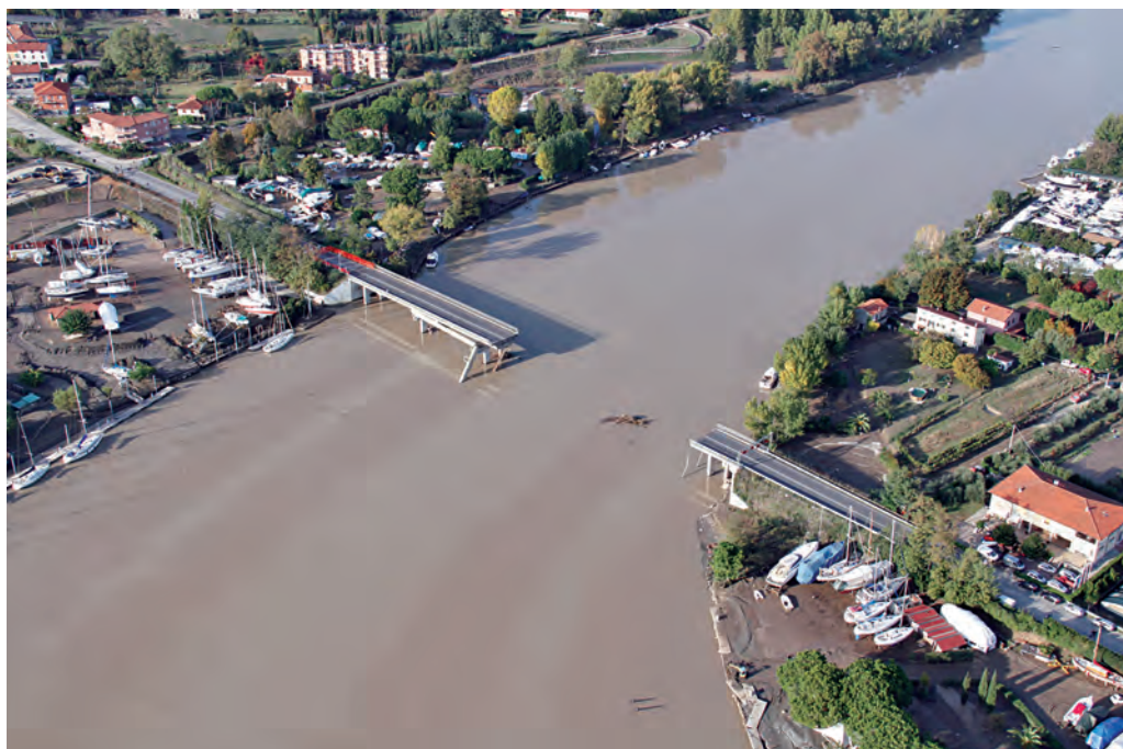
Il ponte Colombiera sul Magra è stato portato via dalla furia di un fiume in genere sonnolento. Un anno dopo anche la struttura provvisoria è stata chiusa in attesa di tempi (meteorologici) migliori
