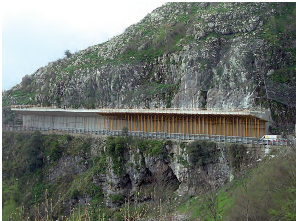
La galleria paramassi in costruzione sulla Statale degli Alburni, a San Rufo. È stata pensata per avere un basso impatto ambientale
