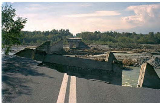
Il fiume Orco durante l'alluvione dell'ottobre 2000: vista dall'alto dell'esondazione e un ponte della Statale 565 Pedemontana distrutto dalle forze delle acque
