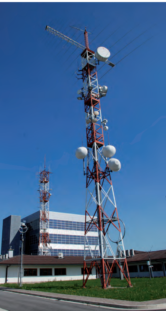
La Centrale operativa di Palmanova vista dall'esterno
